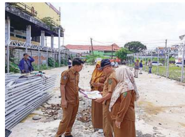
BONGKAR : Pemkot Bengkulu melakukan pembongkaran awning di sebelah PTM Kota Bengkulu.
